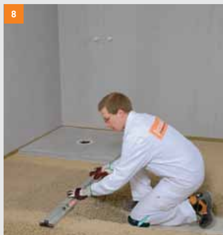
7 Připraveným Rychlotuhnoucím podsypem se vyplní prostor mezi břehy a stáhne se do roviny.
