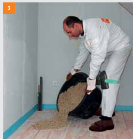
3 Po promíchání vznikne provlhlčená směs s konzistencí odpovídající vlhké zemině
