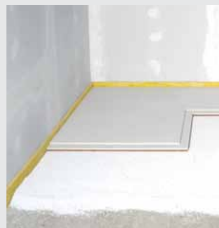
Pokládka podlahových prvků fermacell na vyrovnávací podsyp fermacell
