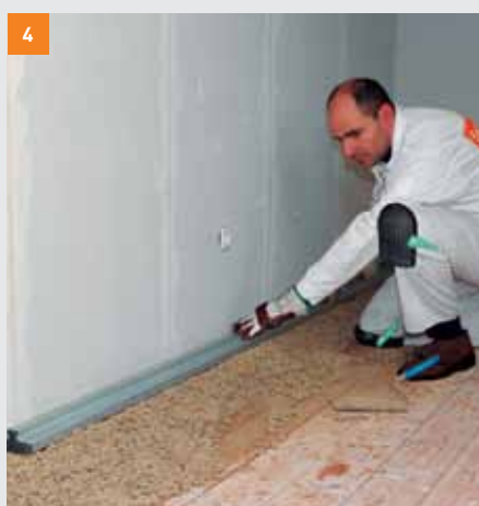
4 Připraví se první břeh pro stahovací lať.
