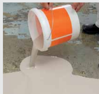
Nivelační hmotu vylijte a vyrovnajte
