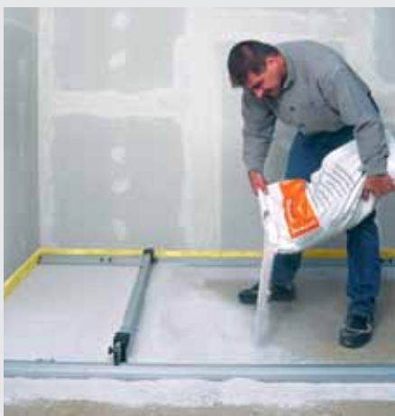
Použití vyrovnávacího podsypu fermacell
