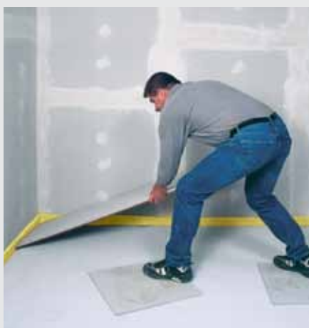
Pokládka podlahových prvků fermacell na vyrovnávací podsyp fermacell
