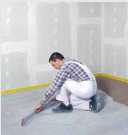
Srovnání voštinového zásypu fermacell
