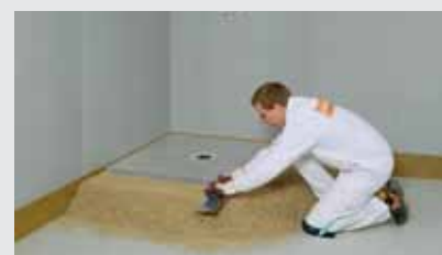
Varianta 1b: kolem sprchového prvku je ve výši přesahujícího stupně nasypána cca 200 mm široká hráz jako základ pro stažení zbývajících ploch
