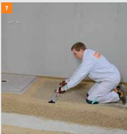
7 Připraveným Rychlotuhnoucím podsypem se vyplní prostor mezi břehy a stáhne se do roviny.
