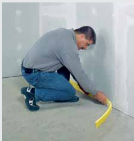
Upevnění krajních izolačních pásek
