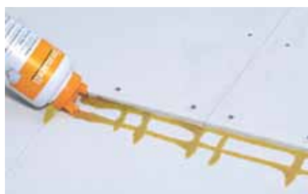
Nanesení lepidla k prolepení 3. vrstvy desek
