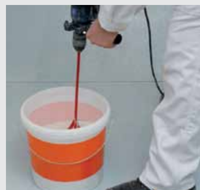
Promíchání vhodným míchadlem při nízkých otáčkách až vznikne homogenní, bezhrudková samonivelační hmota
