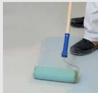
Příprava: penetrace podlahy
