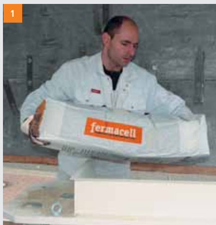
1 Obsah celého pytle se pomocí vhodného míchacího zařízení...
