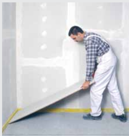
Pokládání podlahových prvků fermacell
