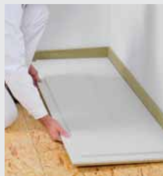
Pokládání podlahového prvku fermacell
