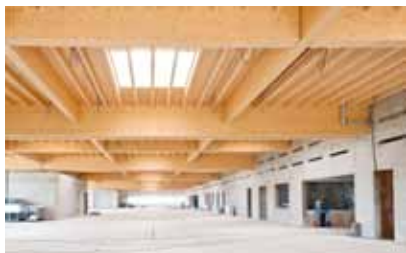
Příklad: střešní konstrukce letiště Kassel ze STEICO LVL.
