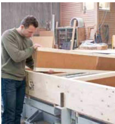
Výroba stěny ze STEICO LVL R a STEICO wall.
