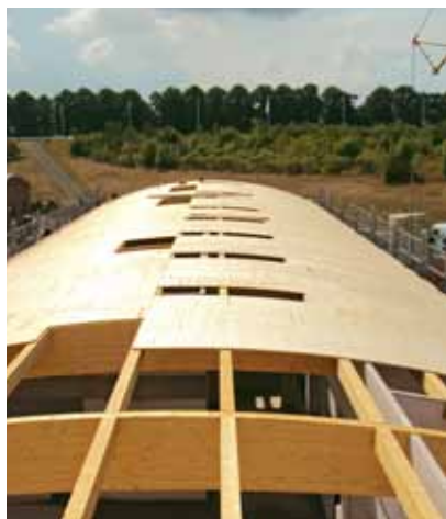
Příklad: Střecha s velkým rozpětím a s vysokou únosností pro haly a objekty
