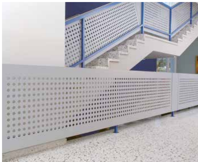
PŘÍKLAD SCHODIŠŤOVÉ VÝPLNĚ ZÁBRADLÍ
